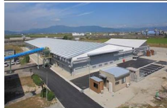
汚泥コンポスト化施設
